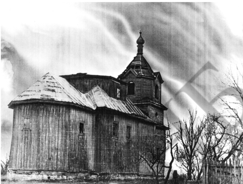
Зруйнована Варашська церква Архистратиґа Михаїла
