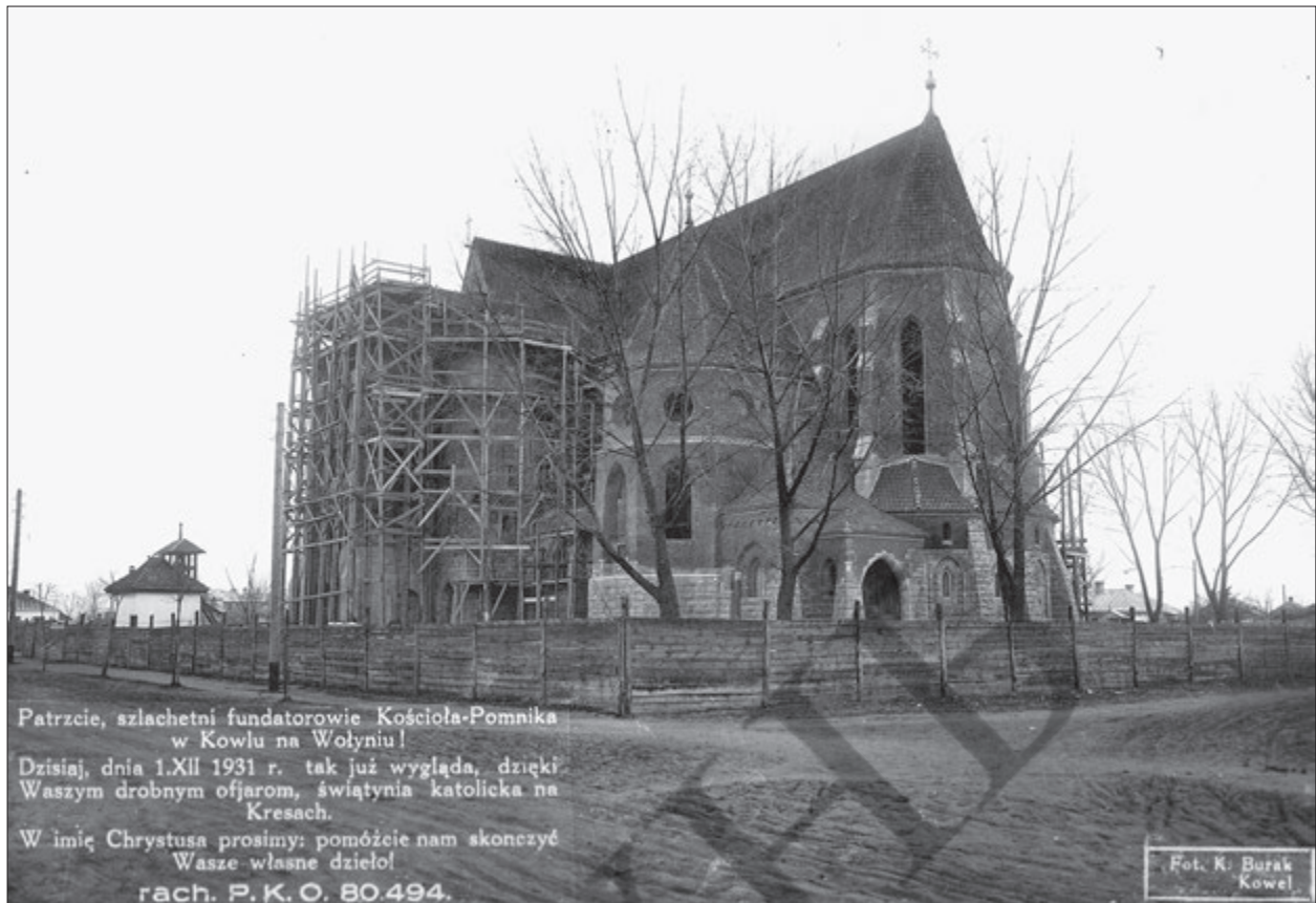
Рис. 1. Ковель. Костел Св. Станіслава в процесі будівництва. Вигляд з заходу. Фото К. Бурака, 1931 р.
