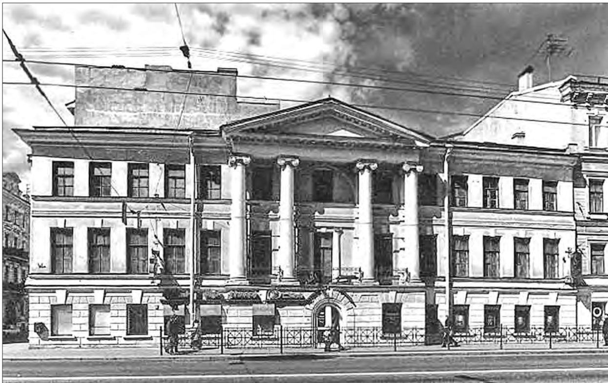
Рис.1. Навчальний корпус Петербурзького інституту цивільних інженерів. 1883 р., архіт. І. С. Кітнер. Фото 2001 р.
