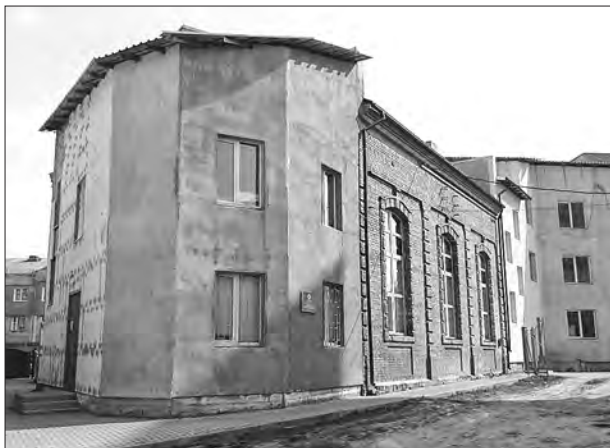
Рис.6. Добудоване до електростанції приміщення. Загальний вигляд з північного заходу. Фото автора, 2012 р.
