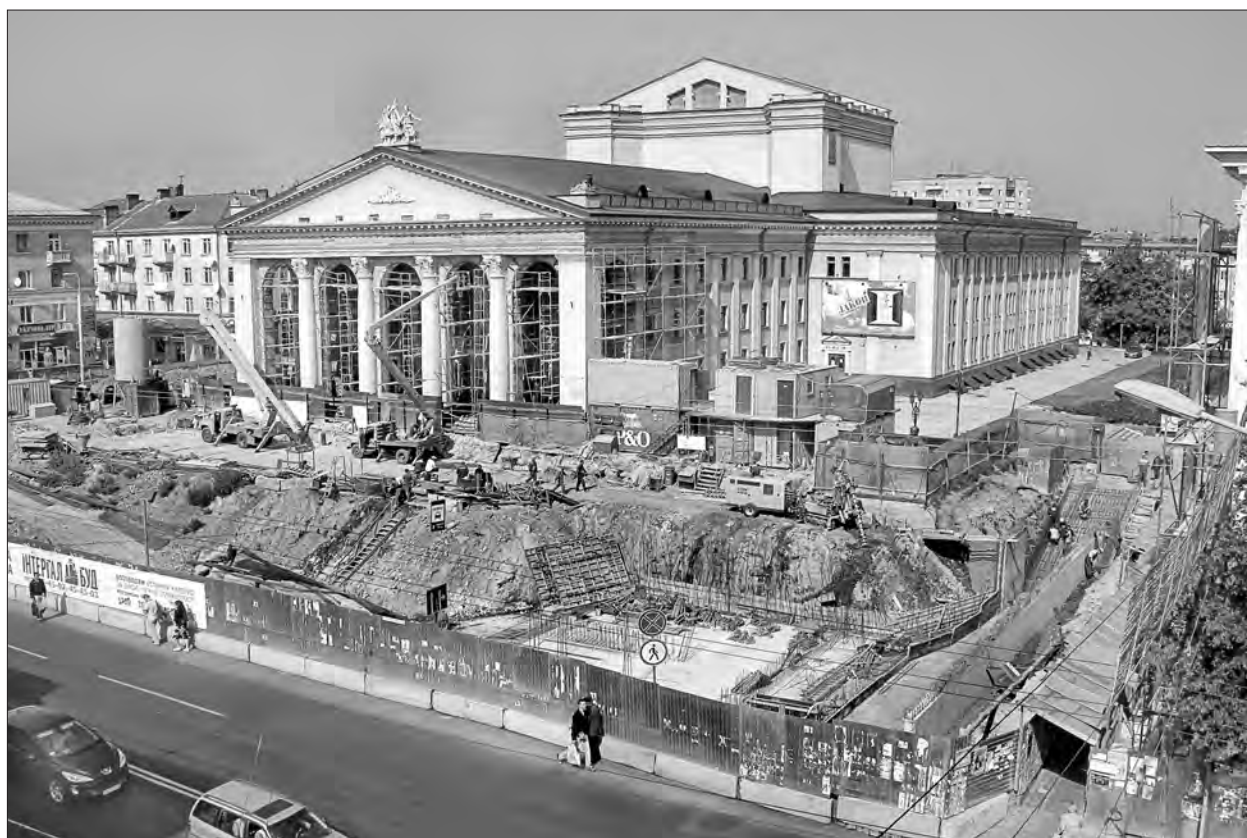
Рис. 9. Будівельні роботи у Рівному на Театральній площі. 2008 р.
