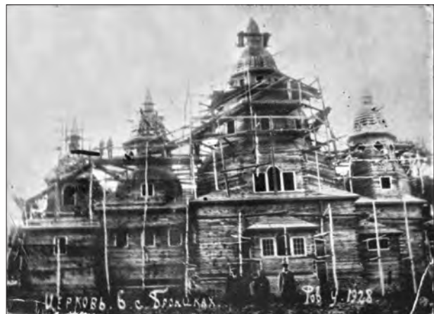
Рис. 2. Покровська церква в с. Бронники на завершальній стадії будівництва. Фото 1928 р., надане настоятелем церкви.
