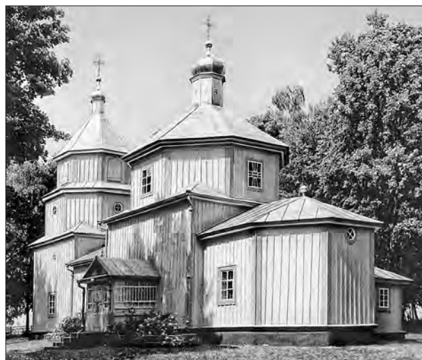
Рис.2. Велика Глуша – церква 1779-1780 рр., ґрунтовно перебудована у 1873 р.
