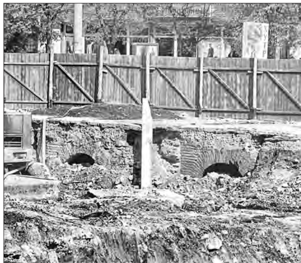
Рис. 4. Залишки міської забудови XIX ст. виявлені при будівельних роботах на площі Короленка.
