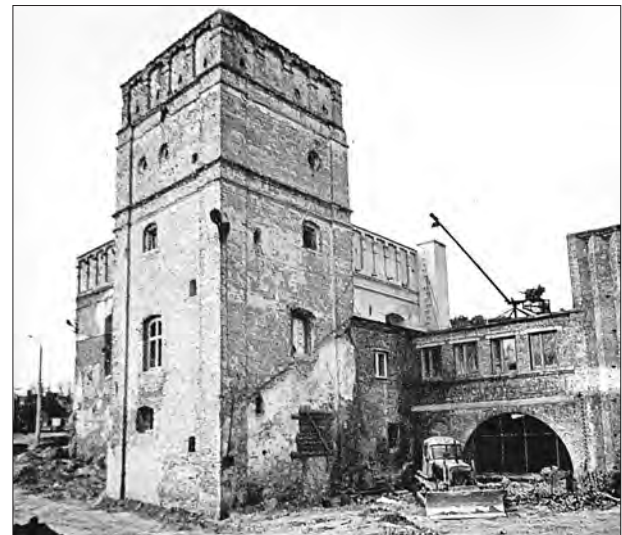
Рис. 12. Синагога в процесі реконструкції. Фото В. Лащенко. 1977 р.
