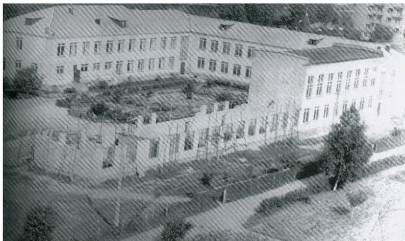
Будівництво нового корпусу школи, 70-ті рр. XX ст.
