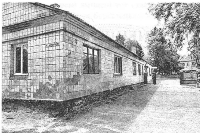
Рис. 3. Будинки які були збудовані голландськими будівниками (перебудовані в наш час), м. Рівне, вул. С. Бандери.
