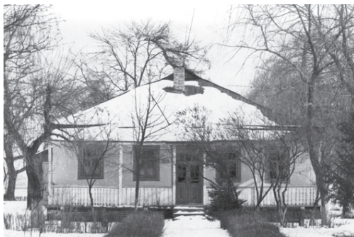
Дільнична лікарня. Терапевтичний корпус до 1983 р.
