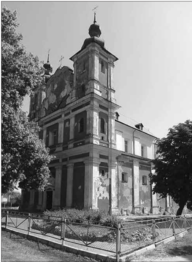
Рис. 5. Стан ремонту костелу 17.06.2016 року.
