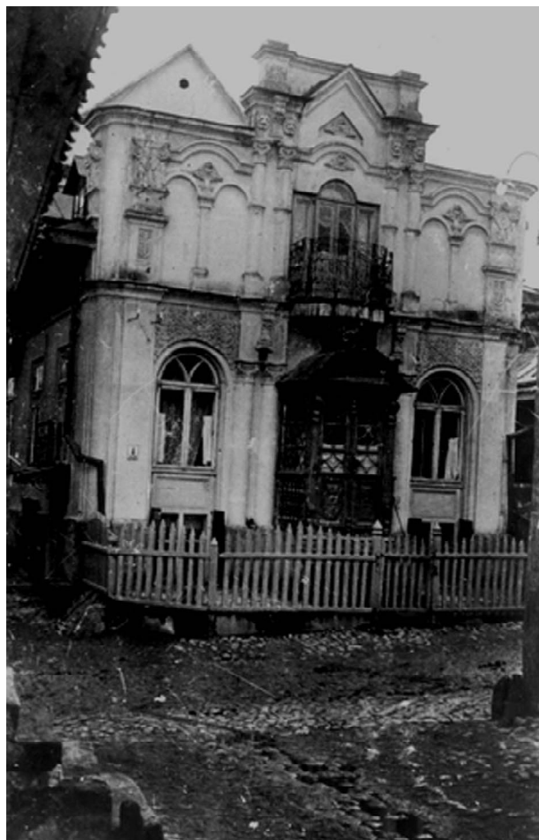
2. Будівля на Єврейській вулиці.
