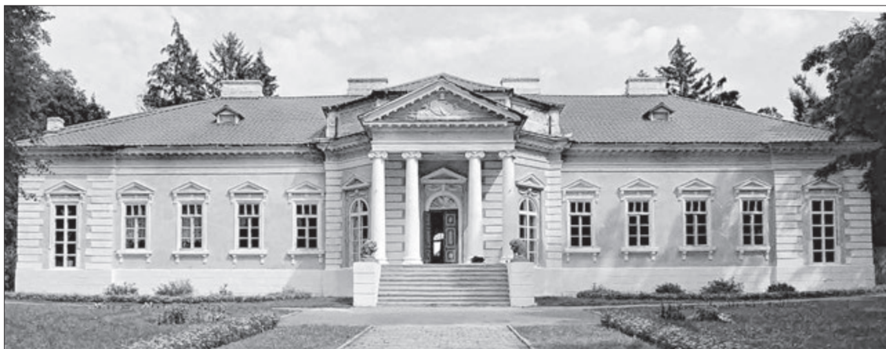
Rys. 2. Samczyki. Pałac, elewacja ogrodowa. Fot. W. Brzezińska-Marjanowska.
