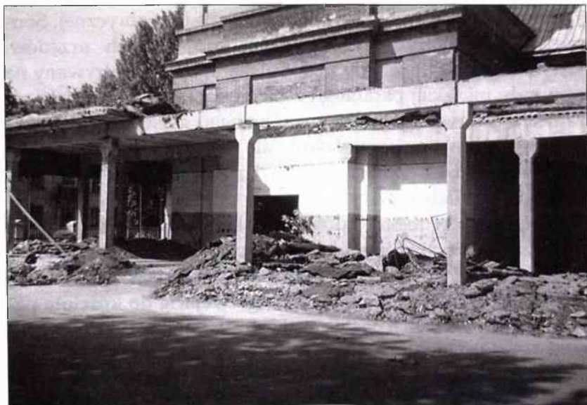
19. Rozbiórka sklepu meblowego zbudowanego przed wejściem do kościoła w Zdobunowie (1993). Fot. ze zbiorów ks. W. J. Kowalowa
