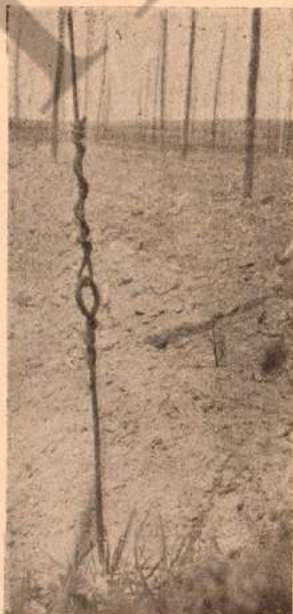
Рис. 15. Прикрѣпленіе тяжа къ якорю.
