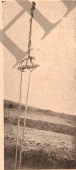
Рис. 20. Сосная тросъ со стержнемъ для перетяжки.
