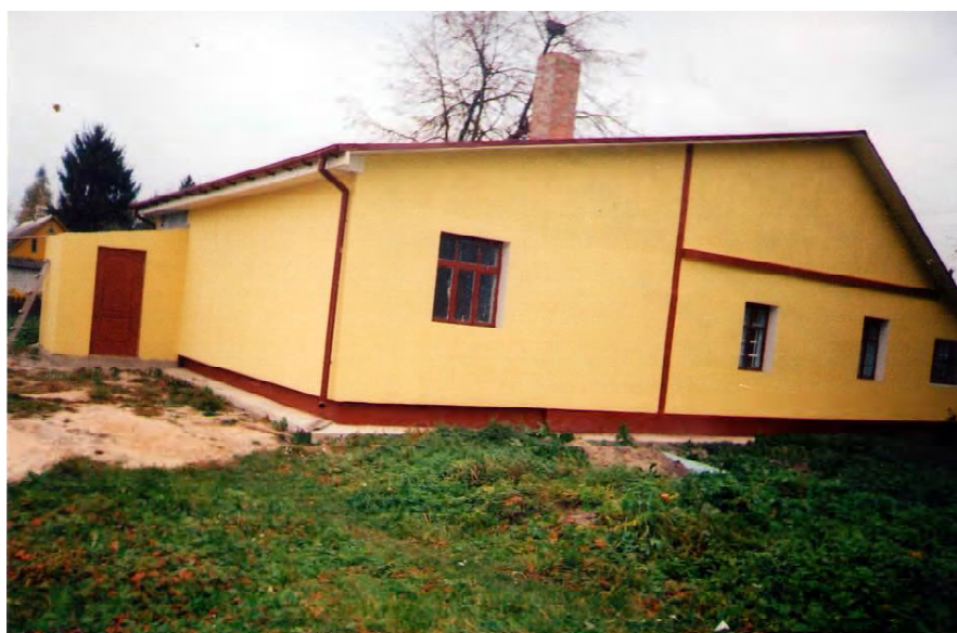
Приміщення після ремонту і добудови.
