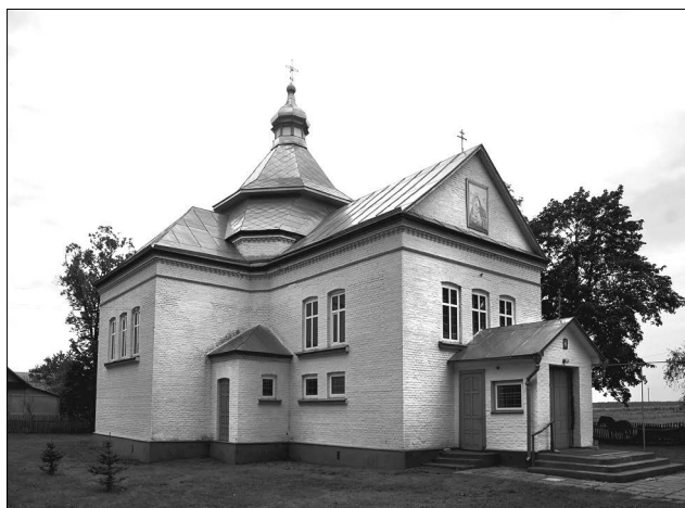
Рис. 3. Загальний вигляд. Фото автора, 2012 р.
