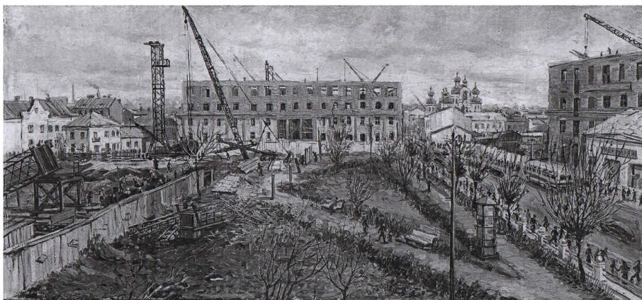
Рис. 7. І. Кузнецов. Рівне будеться. Роботи на будівельному майданчику майбутнього драмтеатру. 1955 р. РОКМ
