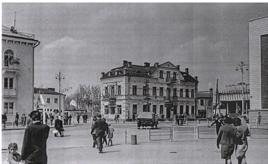
Рис. 15. Будинок коло поштамту знесений під час будівництва площі Леніна (тепер Майдан Незалежності). 1960-ті рр. РОКМ
