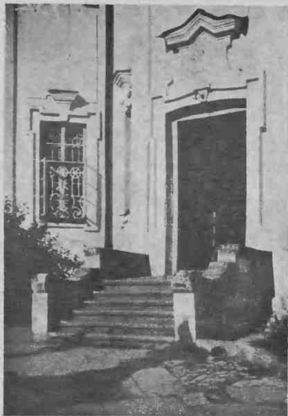
Ryc. 22. Krzemieniec. Kolegium jezuitów. Portal wewnętrznej wieżyczki narożnej. Szk. Prac. Fot. K. L. Fot. H. Hermanowicz.
