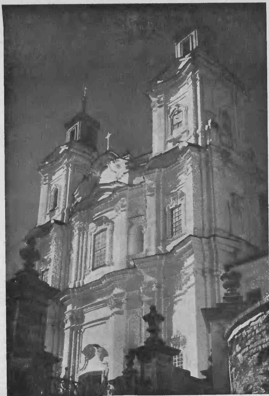
Ryc. 33. Krzemieniec. Kościół jezuitów. Fasada.
