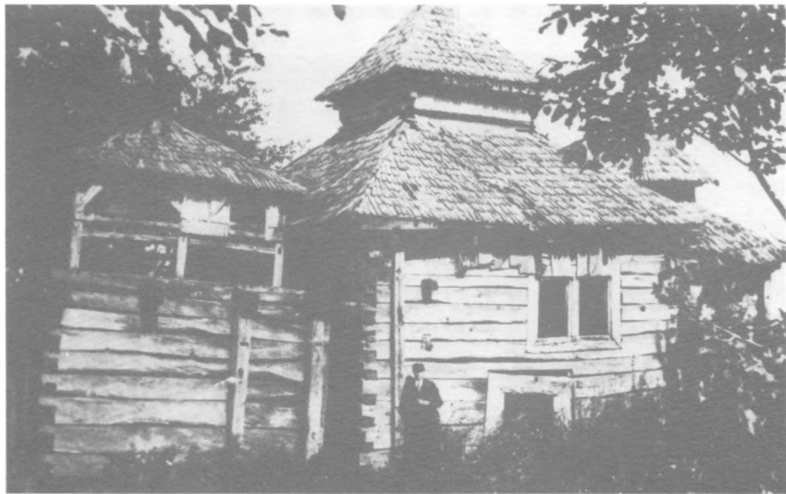
Суходоли -- найстарша оціліла церква до 1936 р., збудована в кінці XVIII ст. кн. Загорськими. Це й був найстарший тип дерев'яної архітектури будови церкви на Волині. Знайдені тут рукописи, патерики й метрики опрацював проф. О. Цинкаловський. Церква була трьохподільна, кожний зруб будови окремо.
