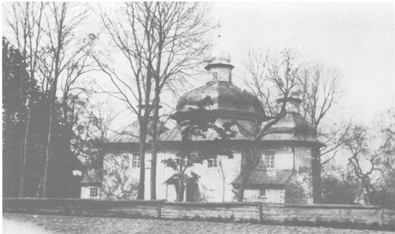
Мизів, пов. Ковель — церква XVIII ст. типова на Волині. Перебудована на початку XIX ст.: знято гонтовий дах і опасання наволо церкви.
