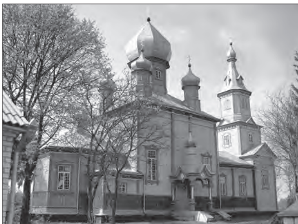
Рис. 1. Вишнівець. Свято-Троїцька церква. Загальний вигляд з північного сходу. Фото О. Смолінської, 2010 р.
