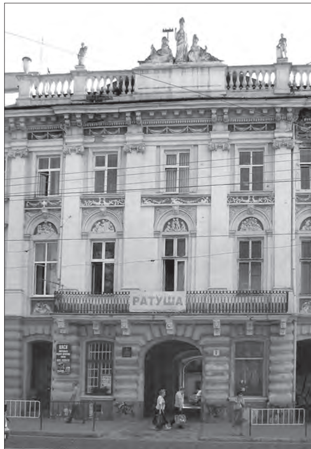
Рис. 7. Львів Кам'яниця Піллерів на вул.Винниченка, 8. Ф.Томек, 1839 р. Площинне трактування ордеру, редукування головного портику, ренесансовий антаблементу у будівлі «ренесансового класицизму»
