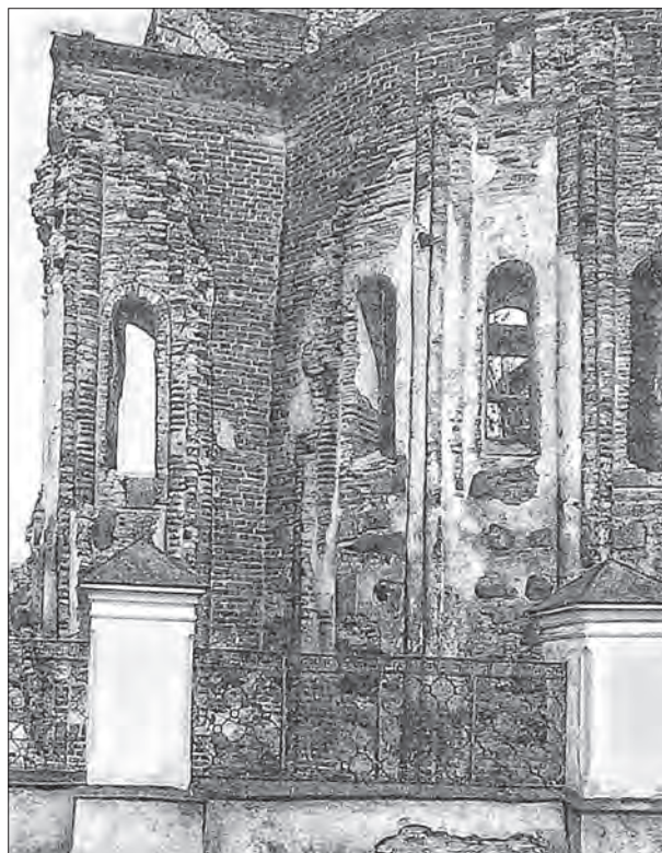
Рис. 16. Овруч. Церква Св. Василя. Східний фасад. Фото до початку реставраційних робіт.
