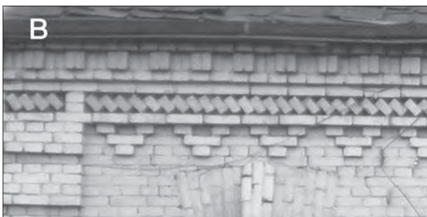
Рис. 5. Луцьк. Цегляна кладка карнизів: а - будинку по вул. Ковельській, 24; б - будинку по вул. Ковельській, 22; в - по вул. Ковельській, 26. Фото І.Абрамюк
