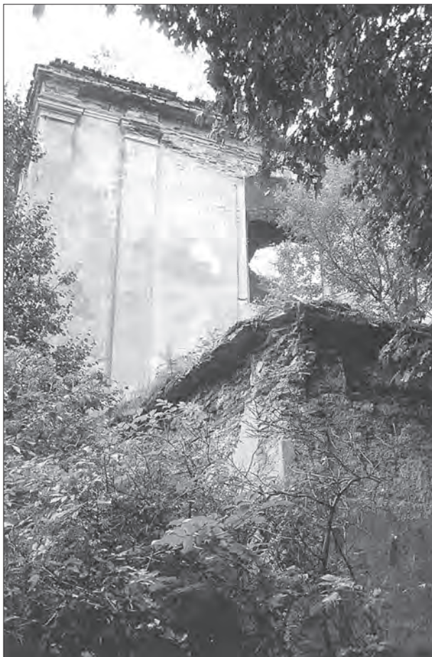
Rys. 9. Tajkury. Kościół parafialny pw. Św. Wawrzyńca. Widok od pn. zach. Fot. M.Kurzej, 2006.
